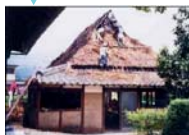
古民家改修の様子
